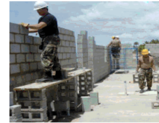
Устройство армированных каменных стен
