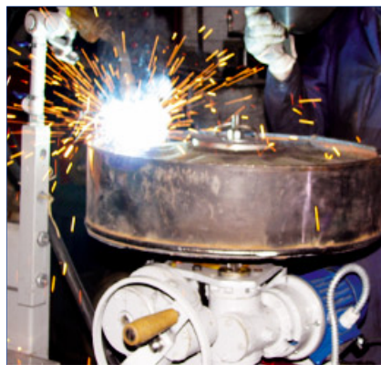
Наплавка торцевых поверхностей реборд опорных катков
