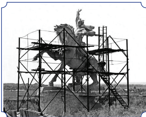
Работы по сооружению памятника А.В. Суворова в Тирасполе. 1979 год
