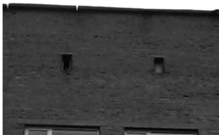
Рис.3. Вентиляционные отверстия чердака
