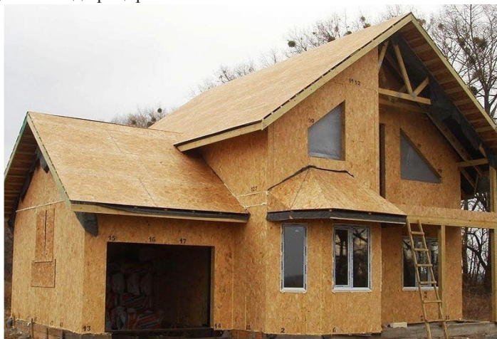
Рис. 1. Малоэтажное здание из сэндвич-панелей и облегченных конструкций
