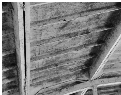
а) Следы замачивания плит покрытия
