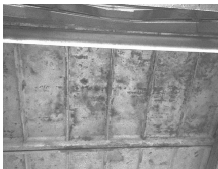
б) Шелушение бетона плит покрытия
