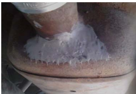
Рис. 8. Ремонт с помощью холодной сварки
