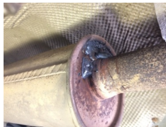
Рис. 7. Ремонт с помощью классической сварки
