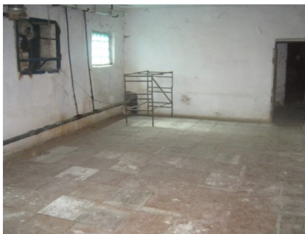
Рис. 1. Подвальное помещение под организацию лаборатории
