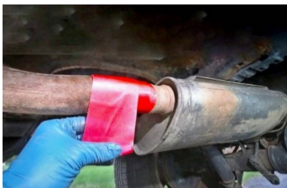
Рис. 9. Ремонт с помощью бандажной ленты
