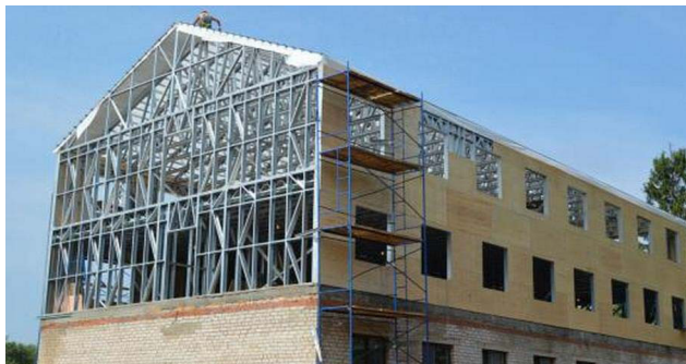
Рис. 1. Реконструкция здания методом надстройки с использованием ЛСТК
