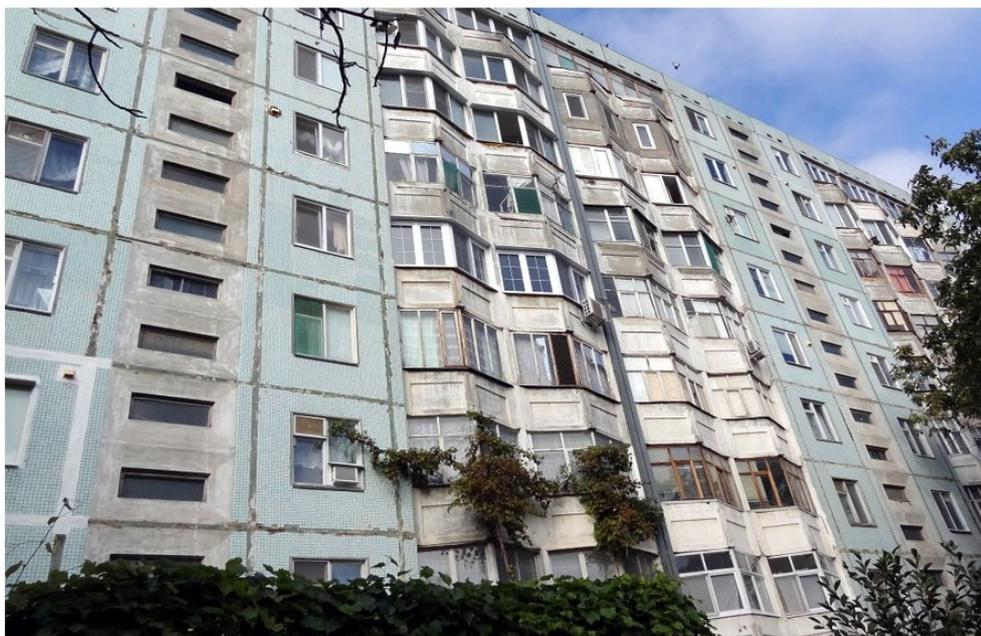
*Рис. 2. Состояние фасада и герметичность межпанельных швов жилого дома по ул. Ленинградской 42, серии Варницкая.*
