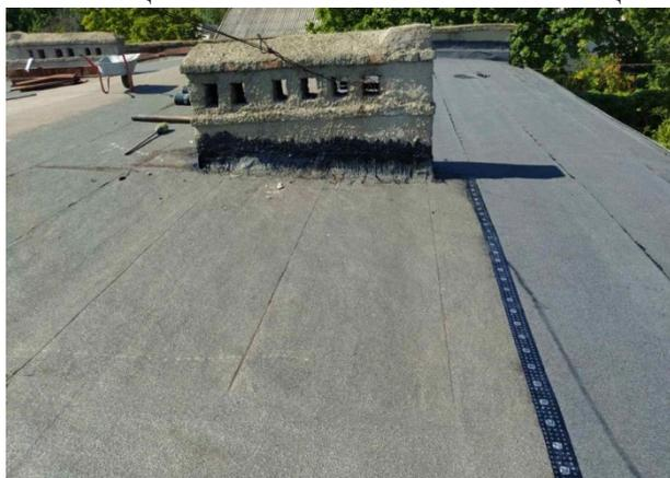
Рис. 5. Состояние кровли жилого дома по ул. Пирогова 8б после замены гидроизоляционного ковра
