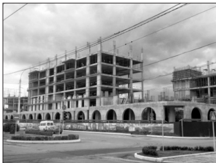
Рис. 2. Улица 25 Октября 69А (строительство нового объекта)
