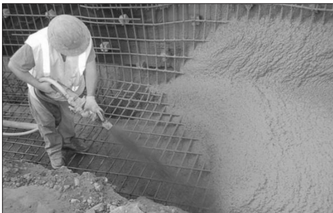
Рис. 2. Торкретирование мокрым способом
