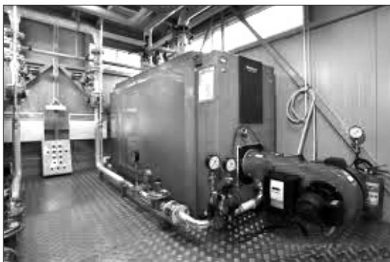
Рис. 1. Модульная котельная
