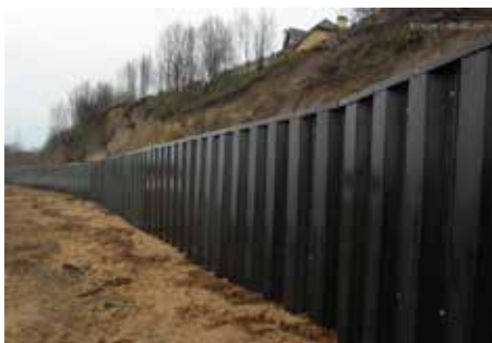
Рис.12. Тонкие шпунтовые подпорные стены
