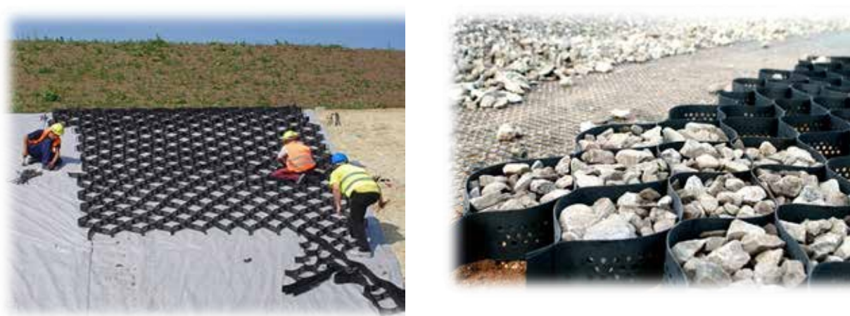
Рис.15. Подпорная стена армированная георешеткой
