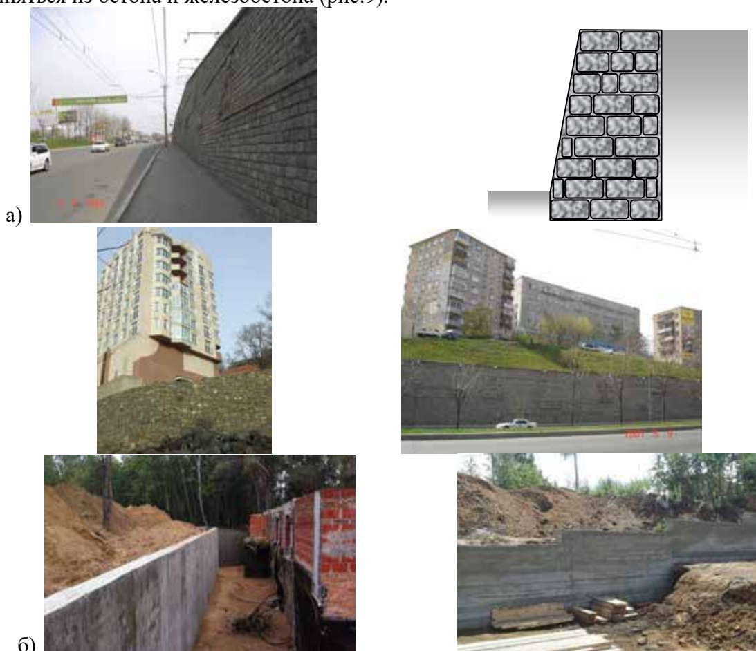
Рис. 9. Массивные подпорные стенки: а – каменные; б - бетонные
