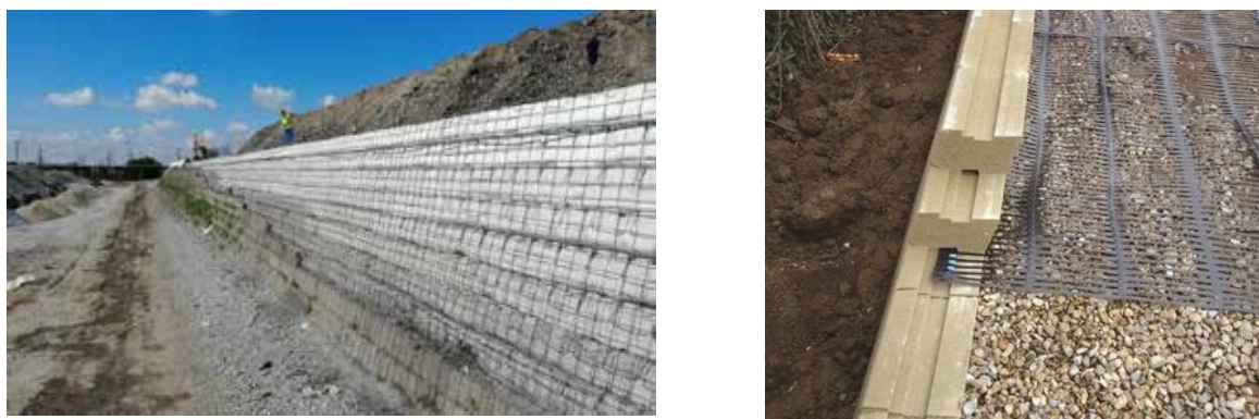
Рис.13. Подпорная стена из армированного грунта
