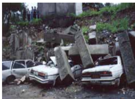
Рис.18. Примеры разрушения подпорных стенок
