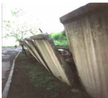
Рис.18. Примеры разрушения подпорных стенок
