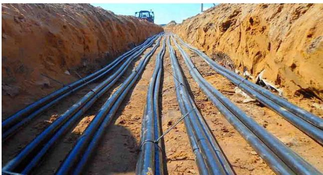
Рисунок 17. Прокладка кабеля в траншее
