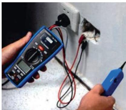
Рисунок 33. Пример проведения испытания проводки
