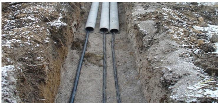
Рисунок 18. Прокладка кабеля в трубах
